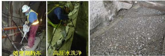
写真 3.6.1 水平打継目の処理
