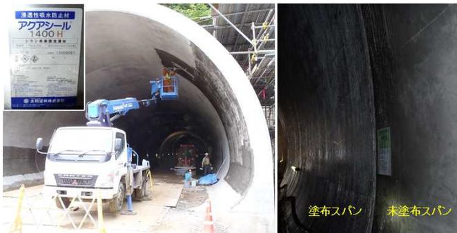
写真 3.8.3 表面含浸材の塗布とその効果
