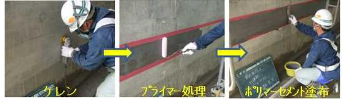
写真 3.6.2 坑門工 打継目の防水処理
