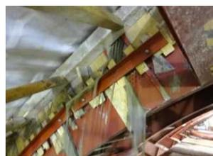
写真 3.7.4 パンチングメタル型枠からのブリーディング水排出
