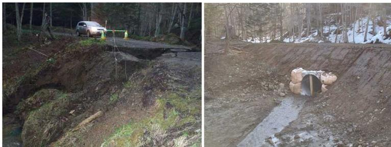
写真 3.3.1 林道の被災状況と排水整備
