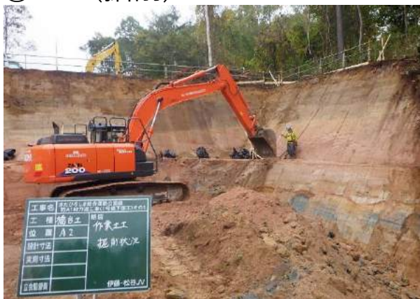
④土工(掘削)
