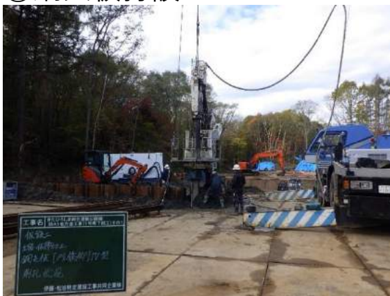
⑤鋼矢板打設
