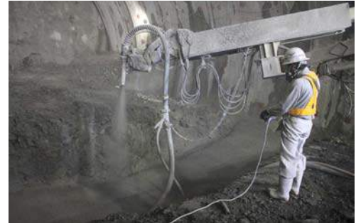
写真-5 インバート吹付けによる早期閉合
