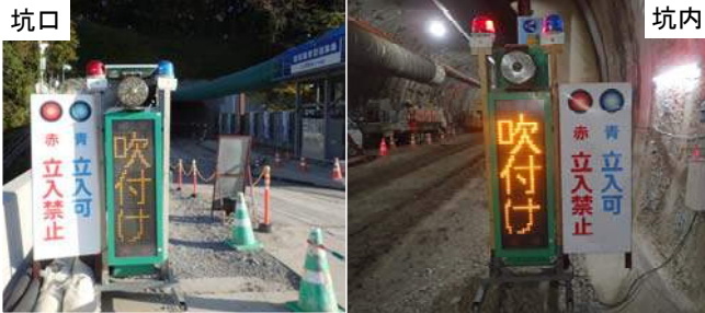
写真-11 坑内作業状況の見える化
