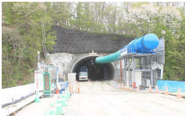
写真-1 見晴トンネル起点側坑口
