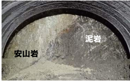
写真-2 泥岩に安山岩が貫入した地質
