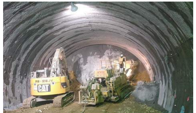
写真-3 トンネル掘削作業
