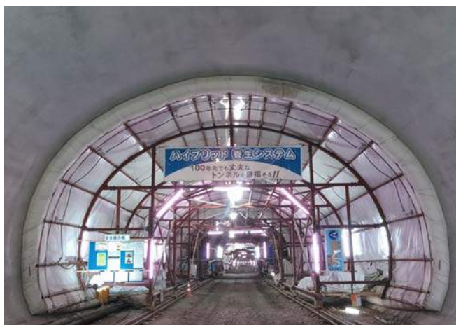
写真-8 ハイブリッド養生システム
