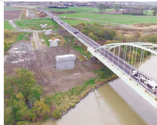
新石狩大橋(江別市)
