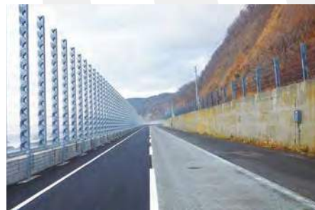
床丹南防波柵(石狩市)
