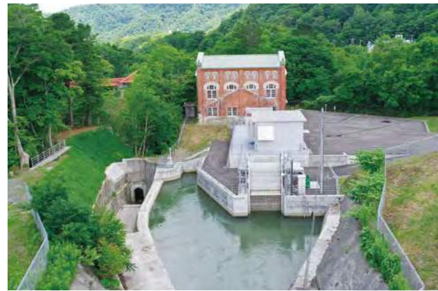
滝の上発電所(夕張市)
