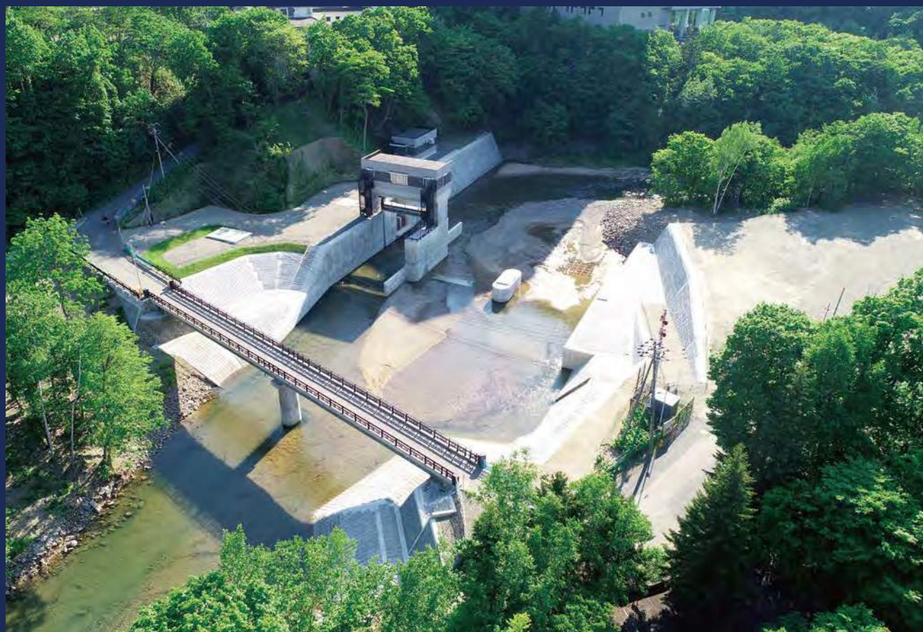
豊平川取水堰(札幌市)
