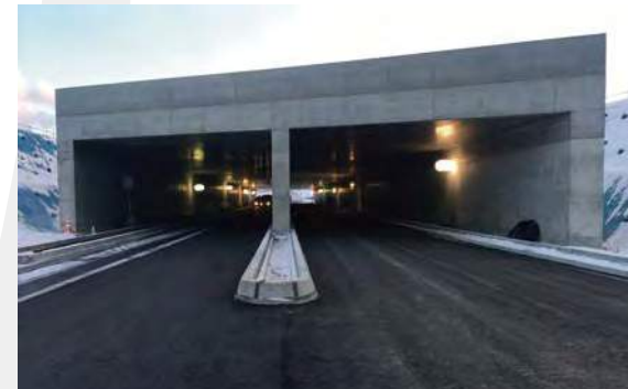
新千歳空港誘導路アンダーパス(千歳市)
