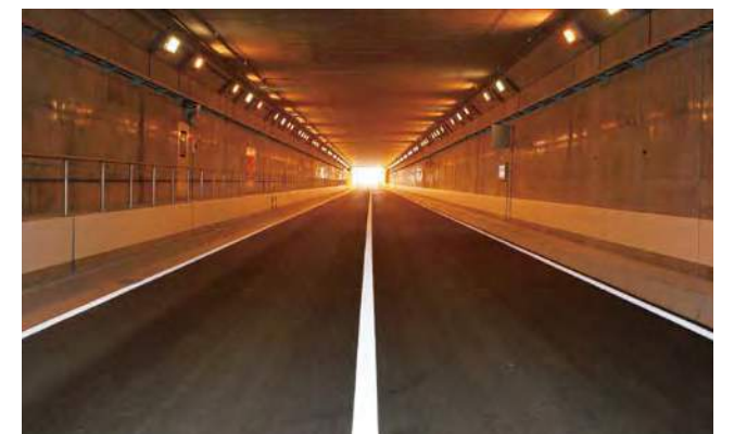
創成川アンダーパス(札幌市)
