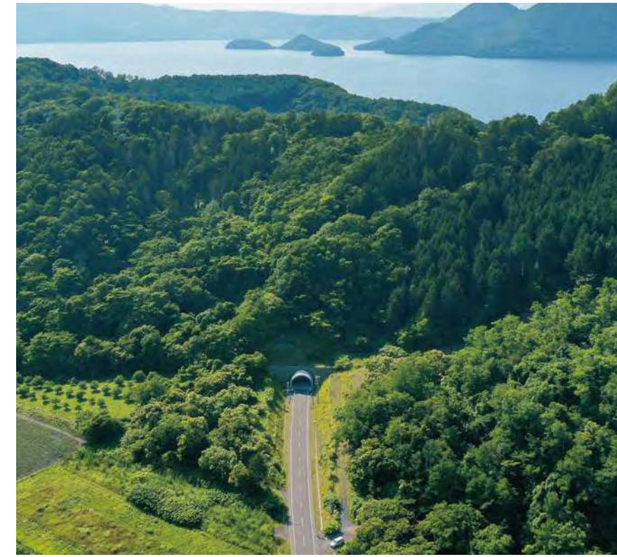
東湖畔トンネル(壮瞥町)
