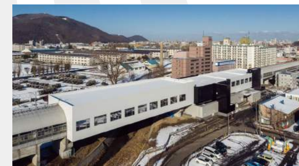
自衛隊前駅耐震改修(札幌市)
