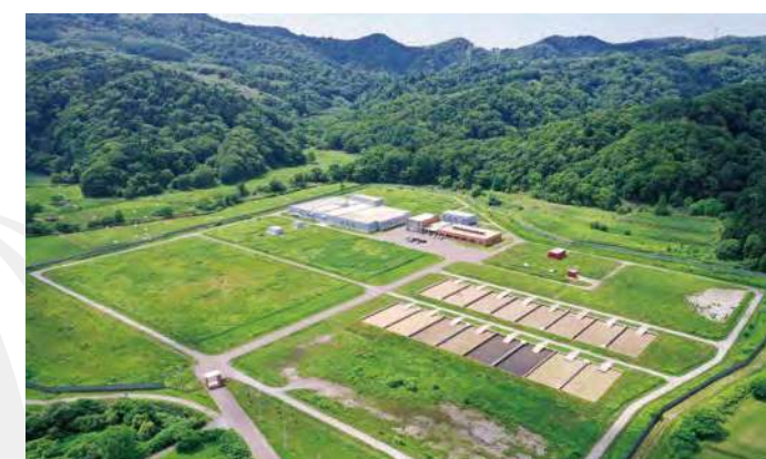
石狩西部浄水場(当別町)
