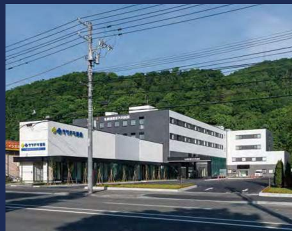
札幌南整形外科病院(札幌市)
