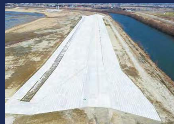
音江別築堤護岸(北広島市)
